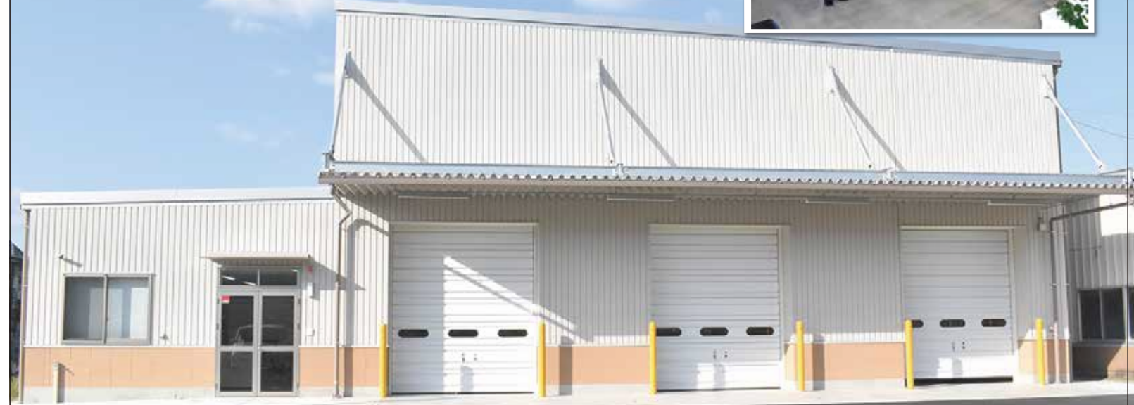
特産センター 柏原町柏原2519番地(柏原営農経済センター横)鉄骨造(延べ面積 910.20㎡)
