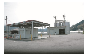
市島糶荷受施設が稼働
