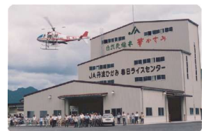
春日ライスセンターの竣工
