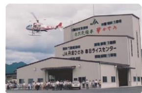
春日ライスセンターの竣工
