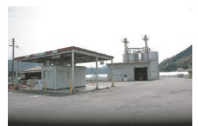
市島糶荷受施設が稼働
