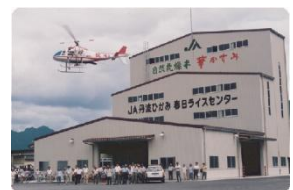
春日ライスセンターの竣工
