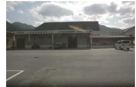
青垣営農経済センターの竣工
